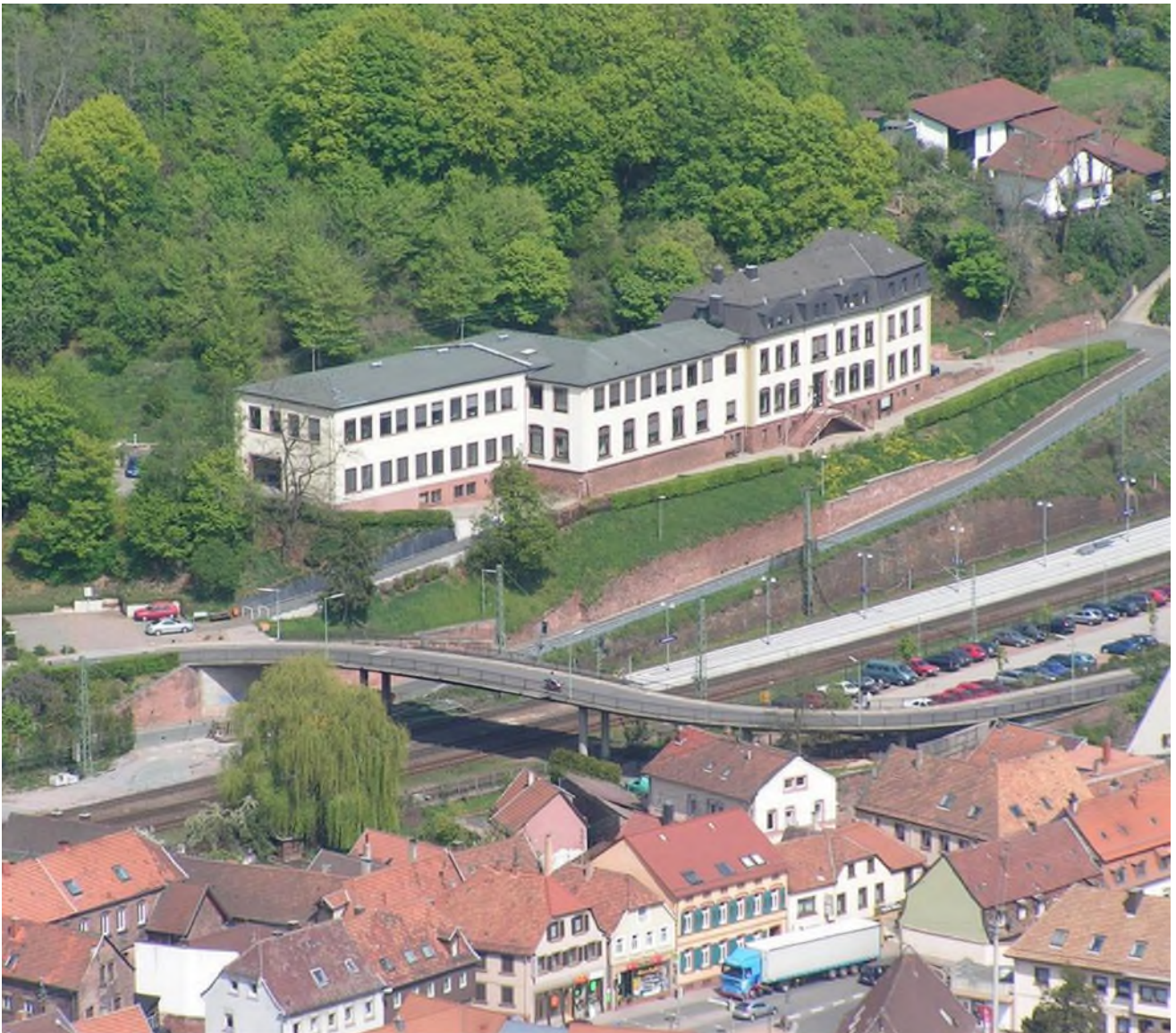
Foto: Verwaltungsgebäude Verbandsgemeinde Lambrecht (Pfalz)
