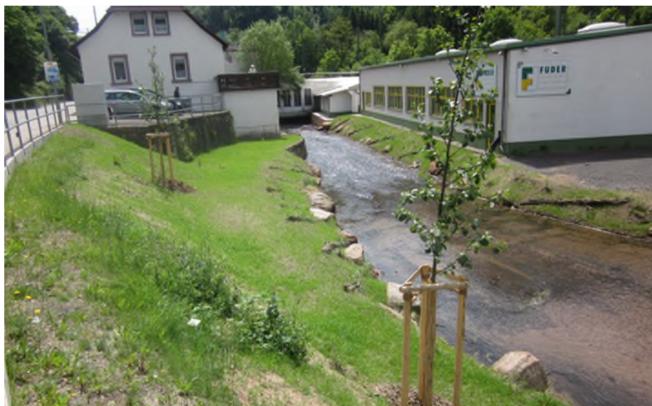
Foto: Fertige Renaturierung Hochspeyerbach Frankeneck
